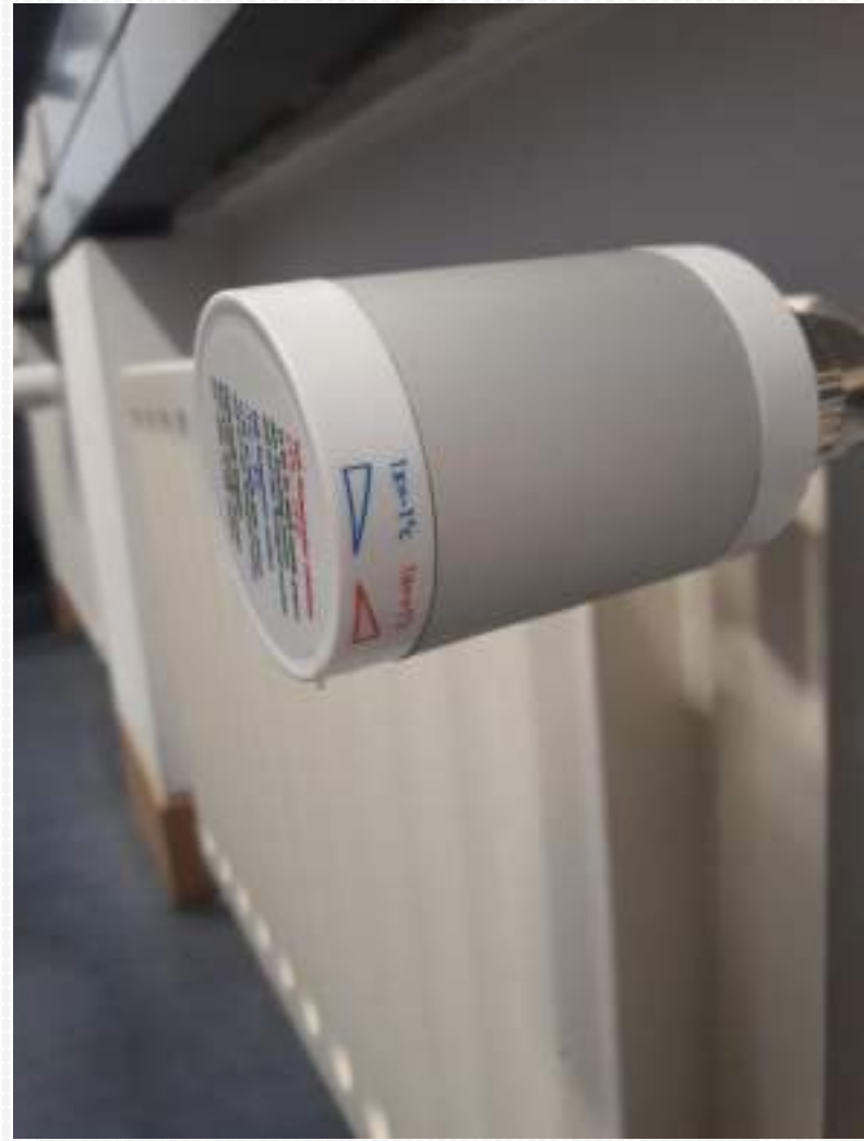
Αριστερά: αισθητήρας θερμοκρασίας, που στέλνει σήμα για πιθανές αλλαγές στη θερμοκρασία του χώρου. Δεξιά: σύγχρονες θερμοστατικές βαλβίδες στα καλοριφέρ.
